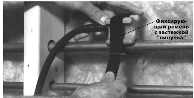
**Рис. 5 – Прикрепление замораживающей головки с помощью фиксирующего ремня с застежкой "липучка"**
