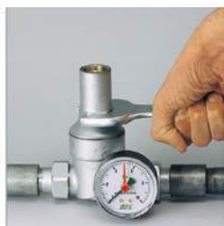
2. Отвинтите колпачок, используя ключ на 32 мм.
