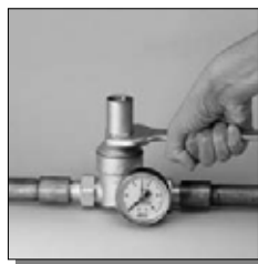
2. Отвинтите колпачок, используя ключ на 32 мм.
