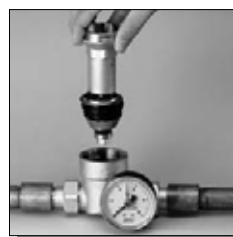
5. Потяните колпачок и вытащите мембрану.
