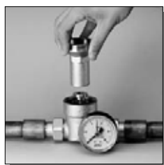
4. Проверните колпачок и навинтите его на регулировочное кольцо.
