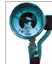
ЭКМ (реле минимального и максимального давления)
