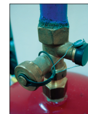
Многофункциональная арматура для расширительного бака
