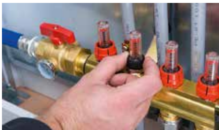
Рис. 4. Полностью откройте шаровые краны и расходомеры.
