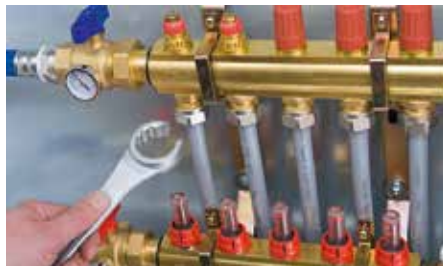
Рис. 2. Затяните гайку компрессионного фитинга с помощью 30 мм рожкового ключа. Отключите коллекторы шаровыми кранами.
