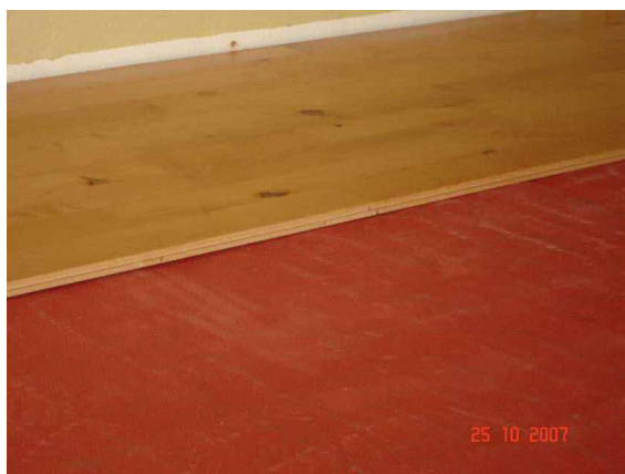
Рис.8. Монтаж покрытия пола.
