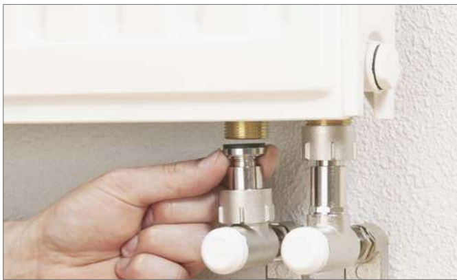
Рис. 18.8. Подключение комплекта телескопических соединительных элементов
