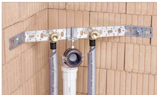
Рис. 6-3. Пример установки монтажной шины
