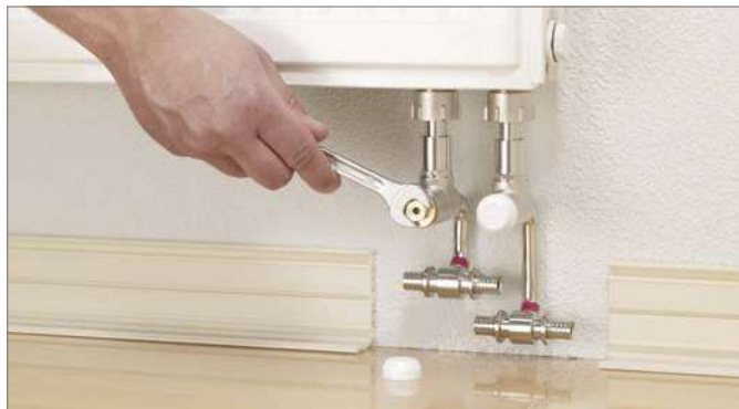
Рис. 18.11. Прочная затяжка резьбового соединения с обжимным фитингом
