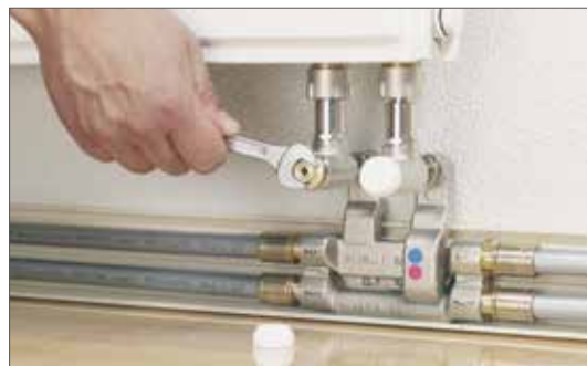
Рис. 16-38 Прочно затяните резьбозажимное соединение.
