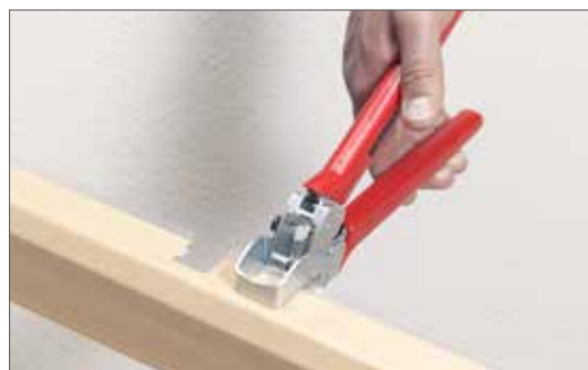
Рис.16-39 Вырезка прямоугольных отверстий в крышке плинтусных каналов
