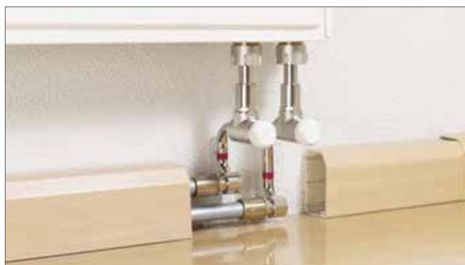
Рис. 16-47 Комплект левосторонних концевых присоединительных трубок SL- RAUTITAN 16 - 12
