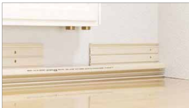
Рис. 16-43 Установленное основание плитусного канала RAUDUO с выемкой
