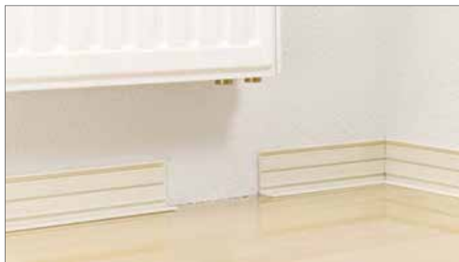
Рис. 16-42 Установленное основание плитусного канала RAUSOLO с выемкой
