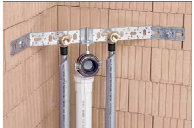
Рис. 5-3 Пример монтажа кронштейна
