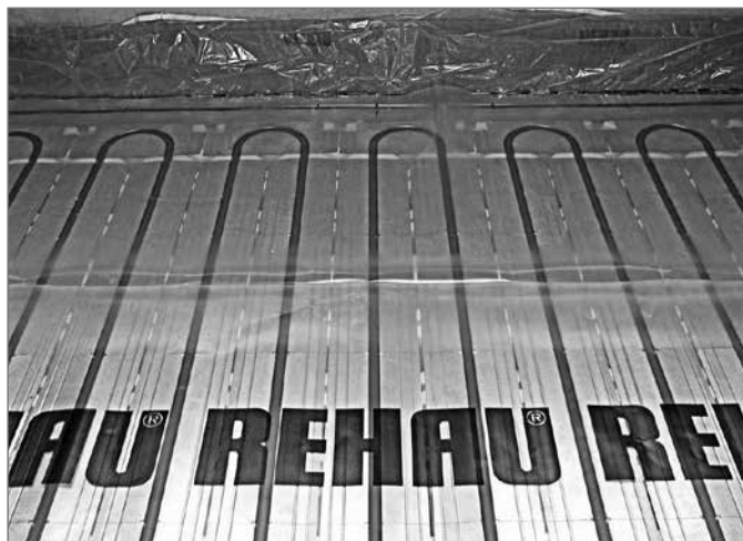
Рис. 22-1 Система укладки труб на теплоизоляционных матах TS-14
