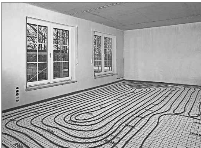
Рис. 21-33 Система крепления труб с помощью гарпун-скоб
