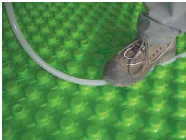
закрепление трубы на шипованной панели
