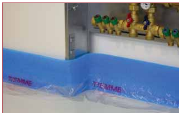
обкладка защитной панели кромочной лентой
