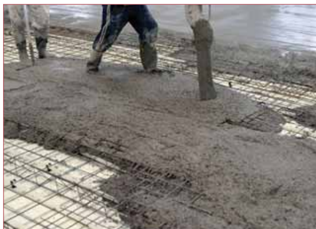
заливание бетонной стяжки в промышленном здании
