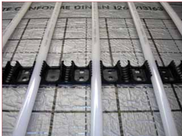
фиксирование трубы в зажимных планках
