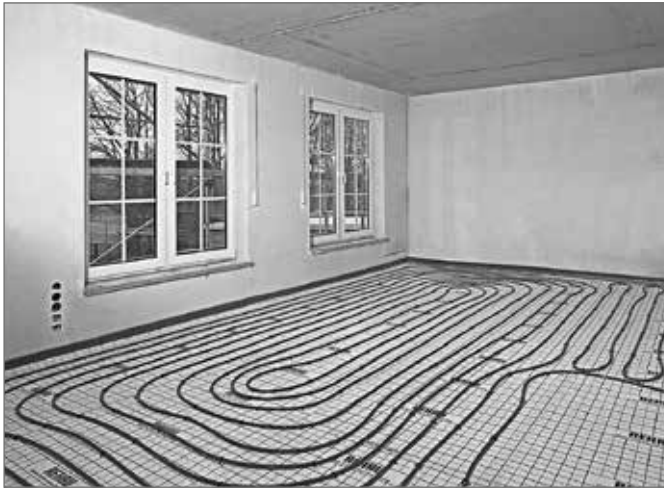
Рис. 15-33 Система крепления труб с помощью гарпун-скоб
