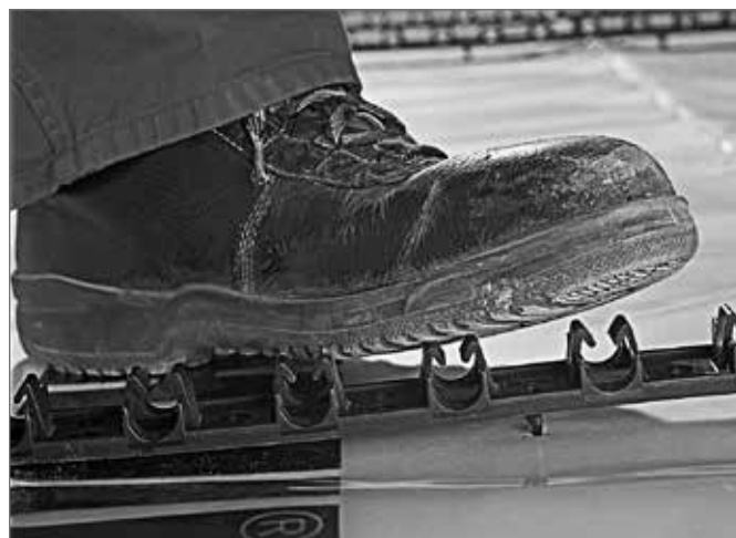
Рис. 15-46 Вдавливание фиксирующих шин RAUFIX в конструкцию пола
