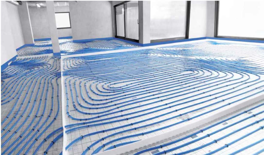
Рис. 24. Напольное отопление, выполненное в системе KAN-therm Tacker
