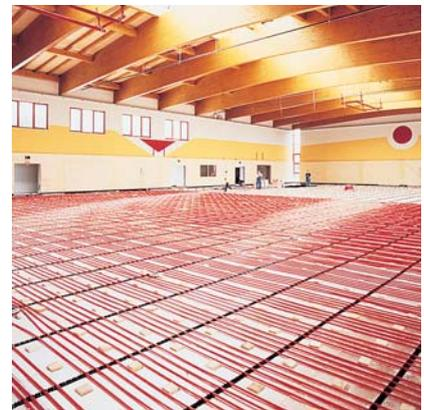
При желании возможно подключение контуров по принципу коллектора Тихельмана. Необходимая теплоизоляция производится при помощи специальных изоляционных плит с вырезами для деревянных колодок. Длительные, и зачастую не точные работы по вырезанию отверстий в изоляции на строительной площадке, отпадают.
