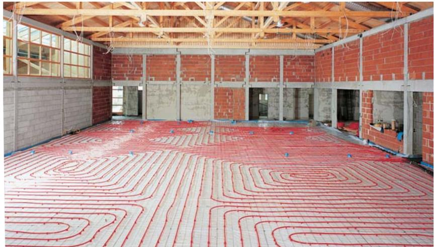
Напольное отопление при этом монтируется в нижней части конструкции вибропола, благодаря чему достигается приятное темперирование поверхности спортивной площадки. Высокая составляющая лучистого тепла обеспечивает благоприятный климат. Предотвращается опасность травмирования об отопительные приборы. Благодаря обогреву большой поверхностью устанавливается
