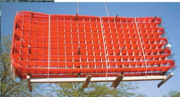
Именно поэтому метод темперирования здания является наиболее благоприятным для окружающей среды и одновременно комфортным. Система для темперирования перекрытий может быть смонтирована на месте или при помощи предварительно подготовленных модулей. Помимо трубы RAUTHERM S и соединения на надвижной гильзе находят применение и другие испытанные компоненты.
