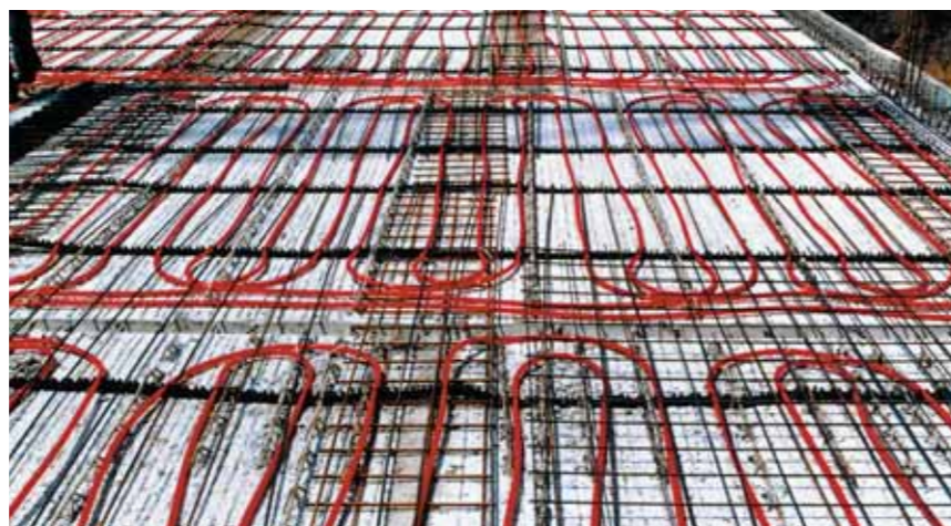
5 Рис. 6: Модули ВКТ REHAU, уложенные на месте перед бетонировкой перекрытия
