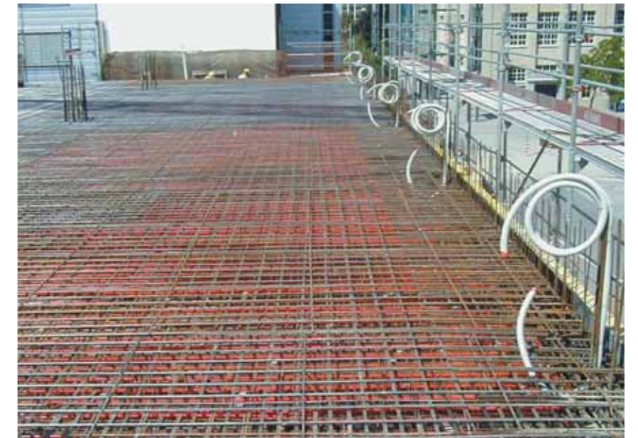
5 Рис. 2: Подготовленная к заливке бетона секция теплоемкого перекрытия ВКТ
