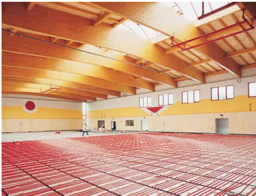
6 Рис. 14: Система REHAU-SBH стандартный распределительный коллектор
