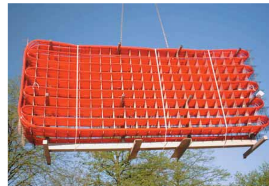
5 Рис. 24: Транспортный модуль ВКТ REHAU
