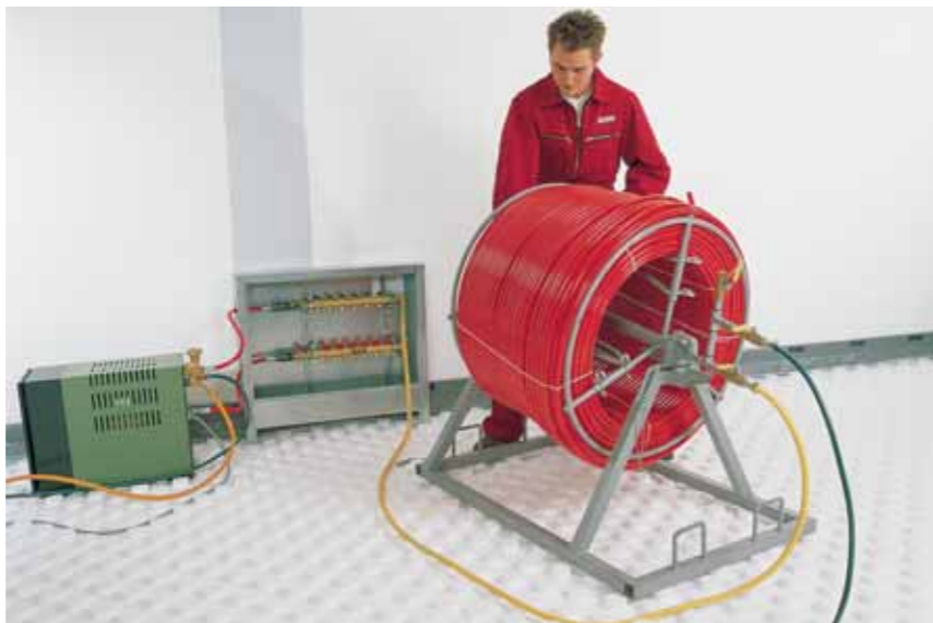
1 Рис. 51: Использование устройства для размотки труб с подогревом
