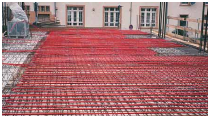
5 Рис. 4: Модуль ВКТ REHAU, закладываемый в перекрытие
