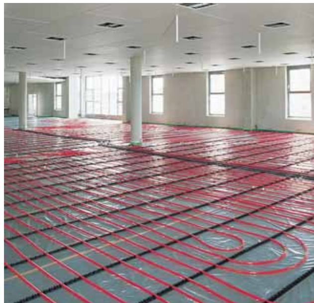
1 Рис. 3: Фиксирующие шины REHAU RAUFIX
