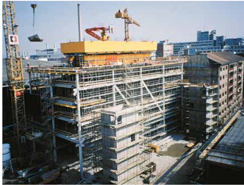
5 Рис. 54: Здание "Выставочной башни" в г.Базель
