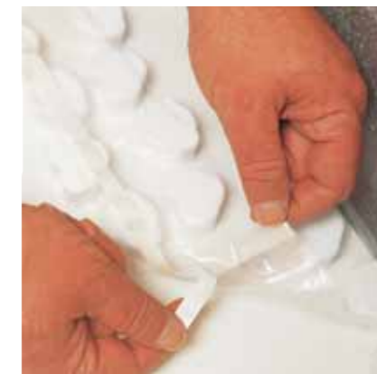
1 Рис. 41: Самоклеющаяся полоса на пленочном фартуке
