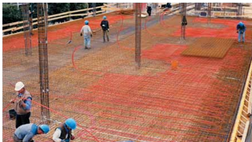
5 Рис. 5: Модули ВКТ REHAU, укладываемые на месте.
