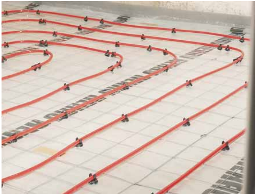
1 Рис. 28: Монтаж по технологии REHAU на арматурной сетке
