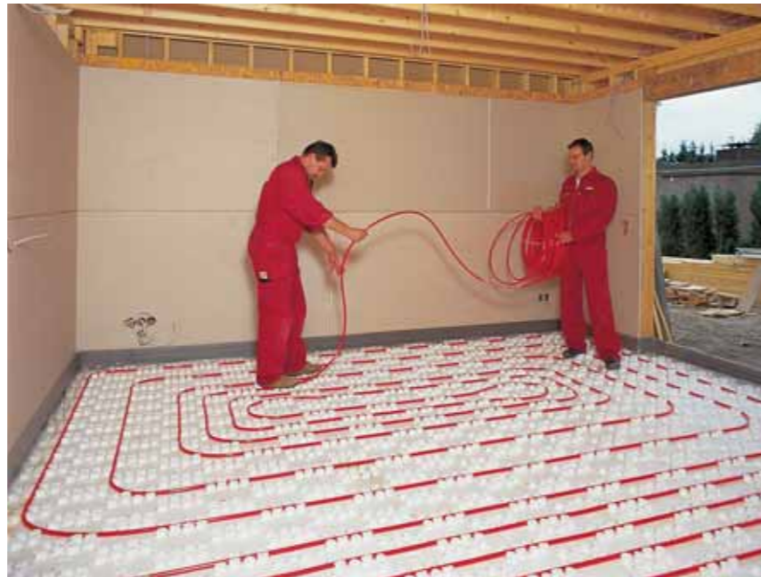
1 Рис. 9: Монтаж на матах с фиксаторами vario
