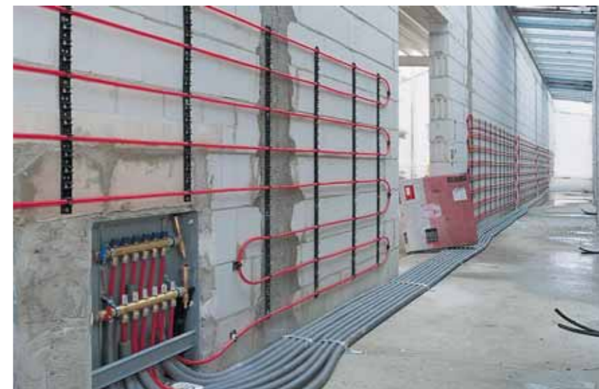
3 Рис. 10: Монтаж системы настенного отопления "мокрым" способом
