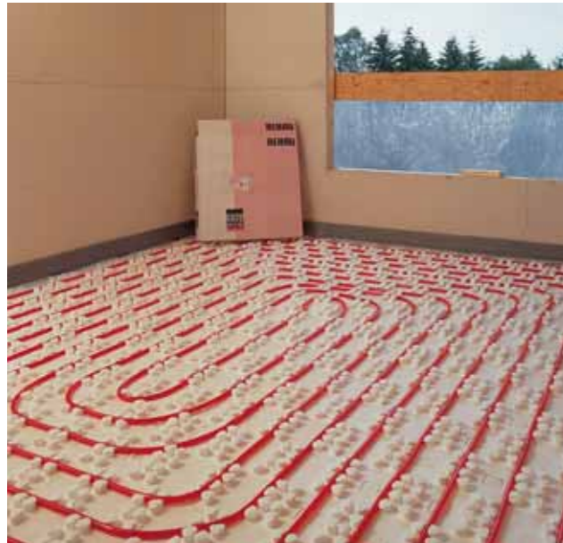
1 Рис. 1: Система крепления труб на маты с фиксаторами varió
