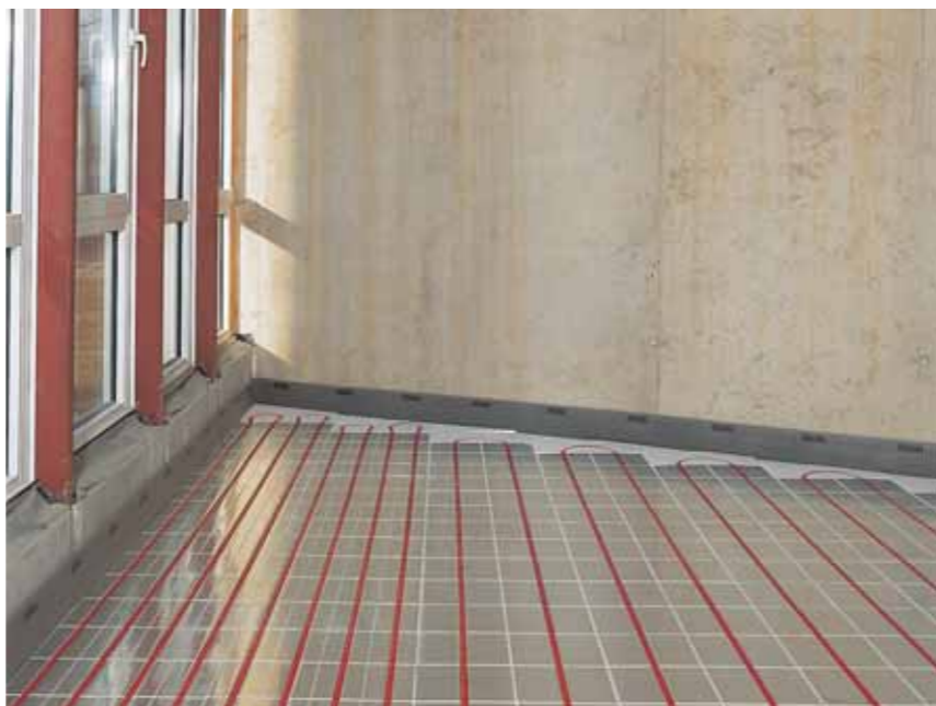
1 Рис. 34: Сухая система укладки REHAU
