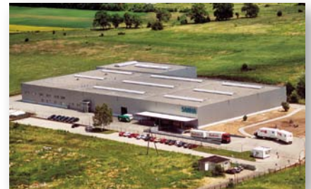
Производственно-логистический центр SANHA, Легница, Польша
