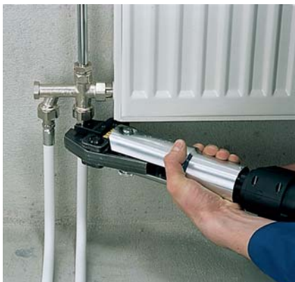
Настольное подключение с помощью присоединительных насадок для одно- и двухтрубных систем
