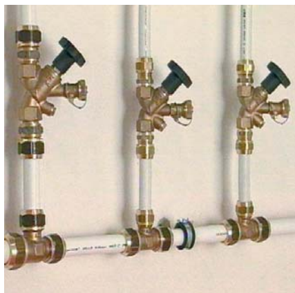
Монтаж арматуры с резьбовым соединением
