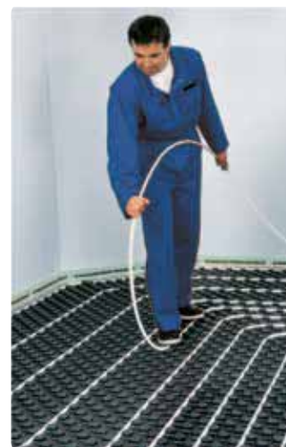
Элементы Uponor Tecto позволяют осуществлять монтаж одним человеком.
