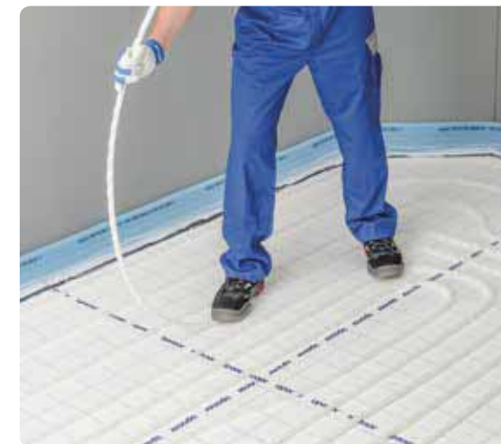
Благодаря инновационной системе крепления вы можете легко и быстро уложить трубы с любым желаемым шагом
