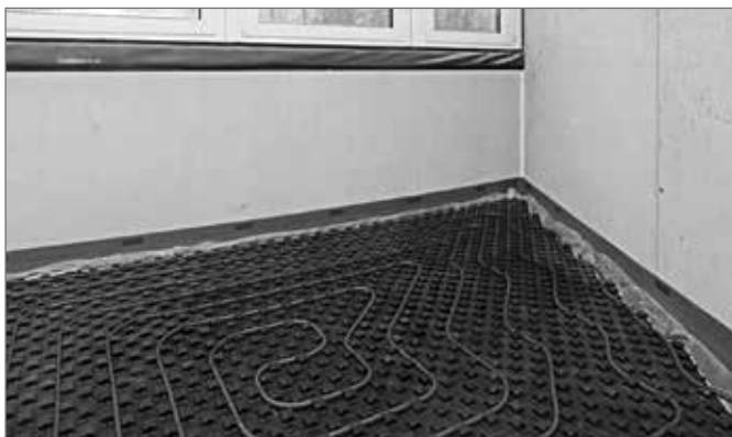
Рис. 15-22 Маты с фиксаторами Varionova с шагозвукоизоляцией 30-2 снизу
