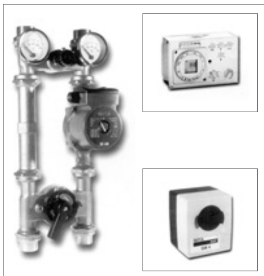
Рис. 7. Смеситель для подпольного отопления, сервомотор SM4 и погодный регулятор - для автоматического регулирования.
