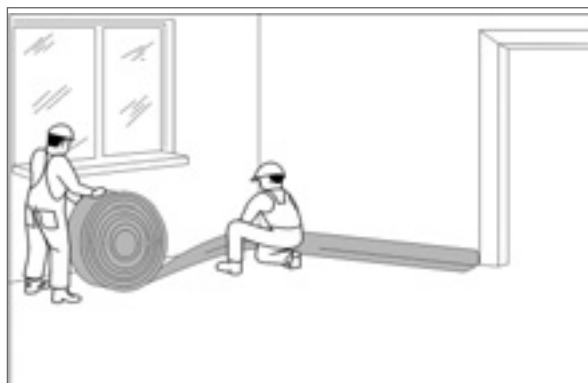
Рис.20. Раскладка под стеной краевой ленты.
