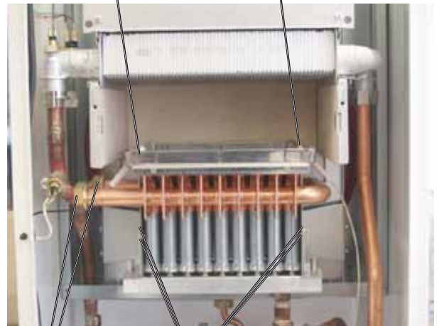
Крепежные болты Компоненты горелки [2]
