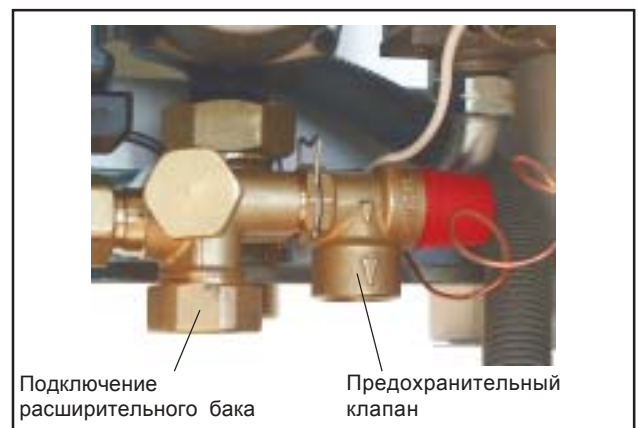
Рис.: Предохранительный клапан, подключение расширительного бака
