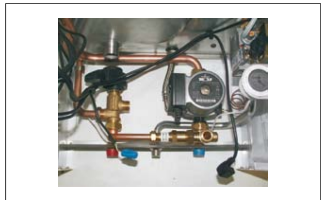
Рис.: Блок подключения демонтирован
