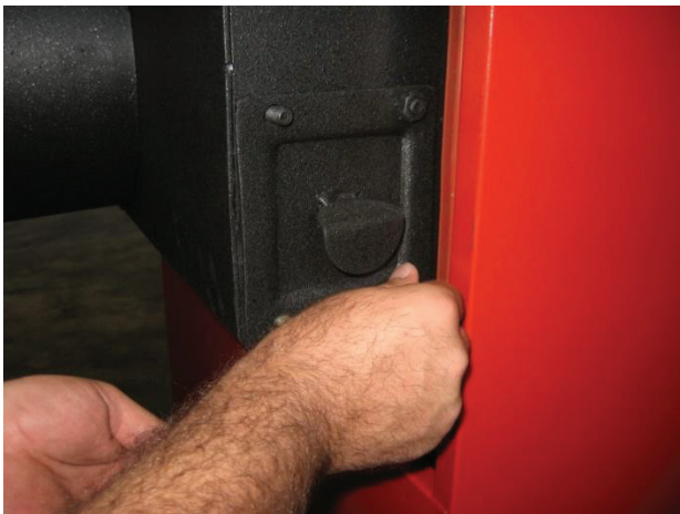
Рис. 9. Снятие заглушки для чистки адаптера дыма .
