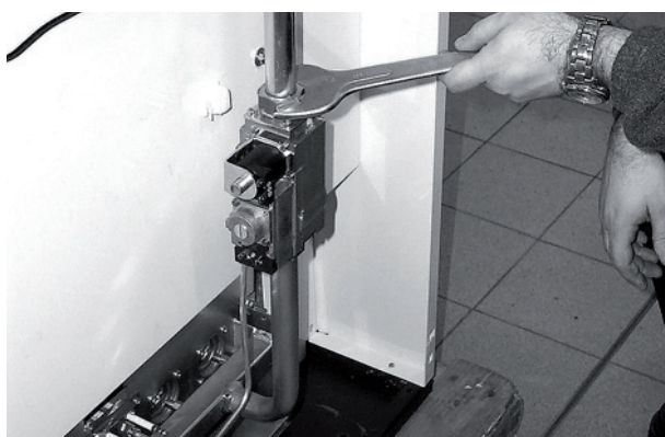
рис. 9 - Открутите гайку крепления газового клапана
