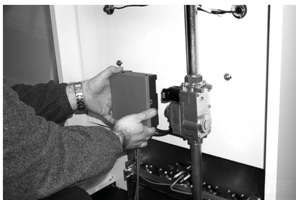
рис. 8 - Снимите блок управления
