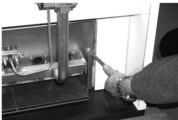
рис. 10 - Развинтите гайки крепления камеры сгорания
