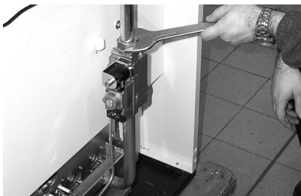
рис. 9 - Открутите гайку крепления газового клапана
