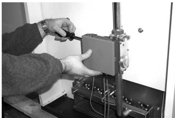
рис. 7 - Открутите два винта крепления блока управления
