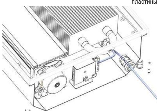
**Рис. 21:** Подсоединить блок управления конвектора. Для подсоединения использовать руководство по подсоединению и регулированию и следовать согласно схемам.
