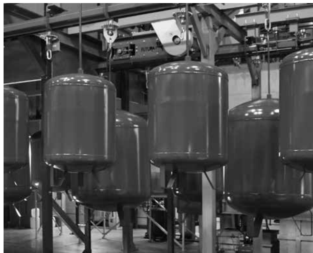
Производственный комплекс "Майбес РУС" расположен в Московской области, Ногинском районе, на территории технопарка "Атлант".
