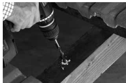
Шаг 2. Сверление отверстия в стропиле
