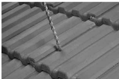
Шаг 1. Сверление отверстия в кровле
