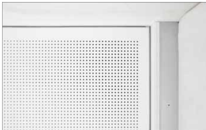
Рис. 4-31 Пример скользящего примыкания к стене
