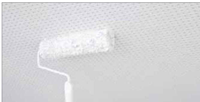
Рис. 4-28 Нанесение краски валиком
