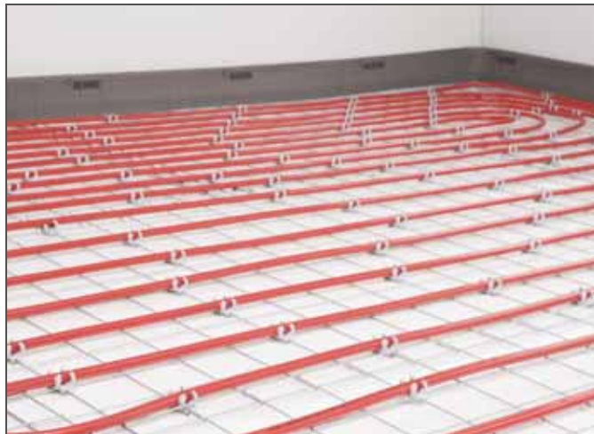
Система крепления труб на арматурной сетке
