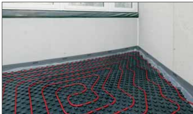
Рис. 3-11 Маты с фиксаторами Varionova с шаго-звукоизоляцией 30-2 снизу
