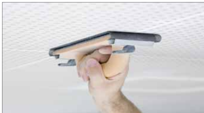
Рис. 4-27 Шлифование поверхности
