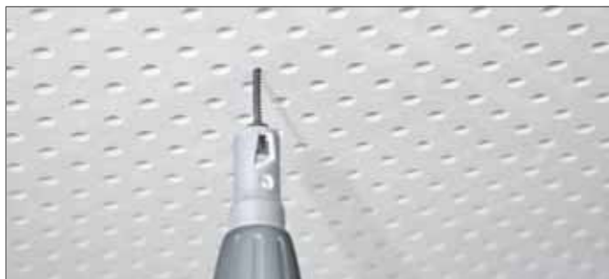
Рис. 4-22 Монтаж гипсокартона шуруповертом с ограничителем глубины
