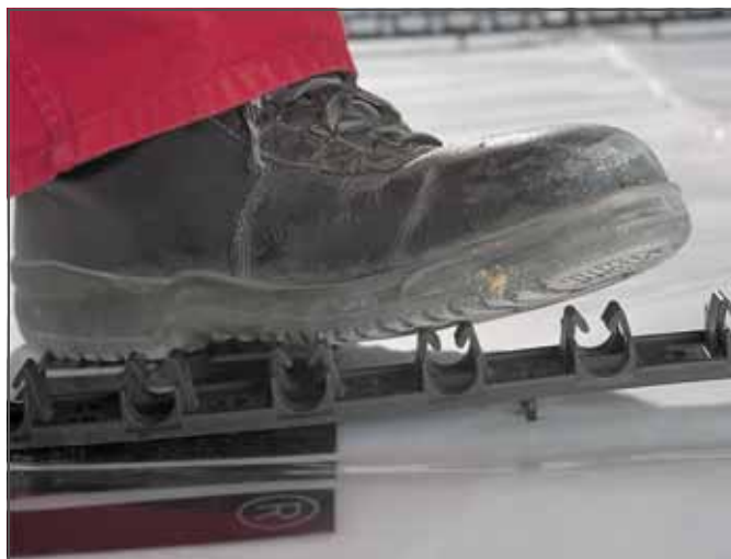
Рис. 3-34 Вдавливание фиксирующих шин RAUFIX в конструкцию пола
