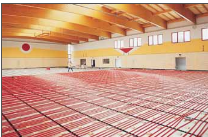
Рис. 14-1 SBH Система со стандартным распределительным коллектором
