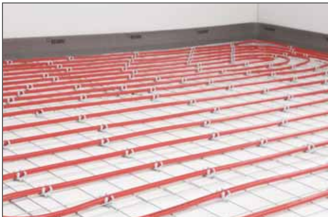
Рис. 3-38 Система крепления труб на арматурной сетке
