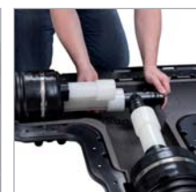
Без задержек наденьте расширенную трубу на штуцер фитинга до упора. Держите трубу до тех пор, пока она не обожмет фитинг. Готово!
