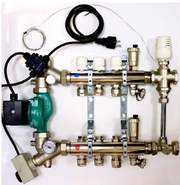
Рис.5.3.1.13.р.1. Насосно-смесительный узел Dual
