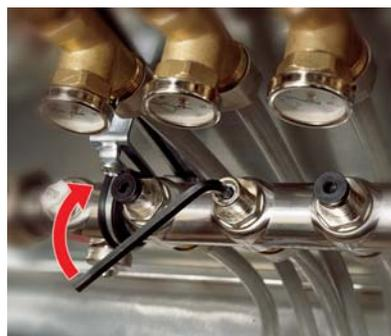
Шестигранным ключом на 6 мм вывернуть юстировочный винт вниз до шпindеля вентиль. Таким образом, эта настройка сохраняется, даже если в дальнейшем вентиль будет перекрыт.
