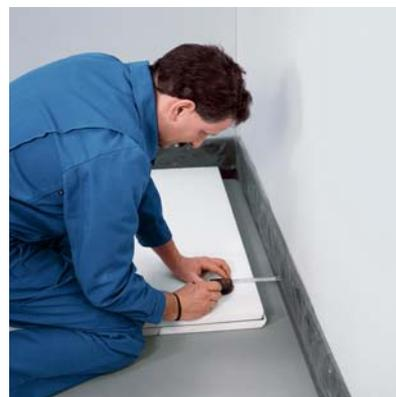
У противоположной стены откинуть конец назад и путем измерения отложить остальной размер.
