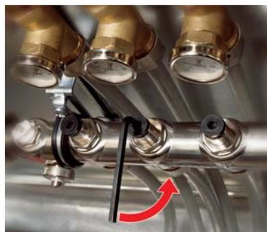
Отвернуть защитный колпачок шестигранным ключом на 5 мм.
