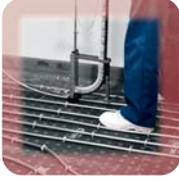
На ровной плоской поверхности прошивных плит системы xnet C12 можно прокладывать **5-слойную системную трубу PE-Xc системы xnet** со следующими интервалами между трубами в соответствии с маркировкой: 5,5/11/16,5/22/27,5/33 см.
