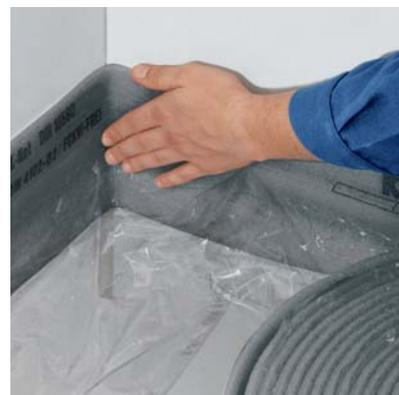
Установить боковые изоляционные полосы вдоль стен по всему периметру, снять клейкую защитную ленту, прижать – и готово!
