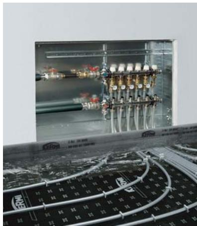
Шина для изменения направления труб обеспечивает точную подгонку при переходе труб к проложенной поверхности и точную посадку экрана бесшовного пола.
