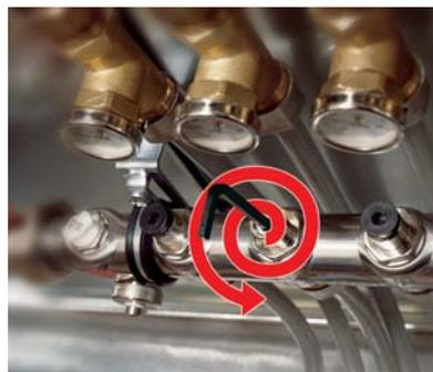
Повернуть шпindel вентиль вверх на расчетное значение, например, на 2,0 оборота.
