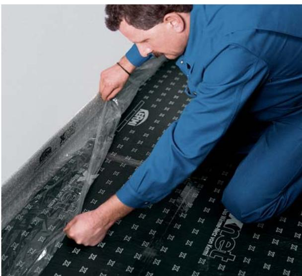
Для цементного бесшовного пола труба в сочетании с пленочной полосой одновременно обеспечивает герметичность. При этом благодаря использованию сверхдлинной пленочной полосы не требуется прокладывать трубу слишком близко к стене.
