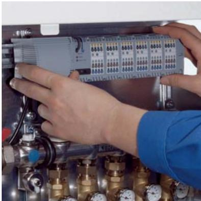
Вставить концы кабеля в соответствии с цветными обозначениями устройств. До нужной длины кабель удобно укорачивать, накручивая его.
