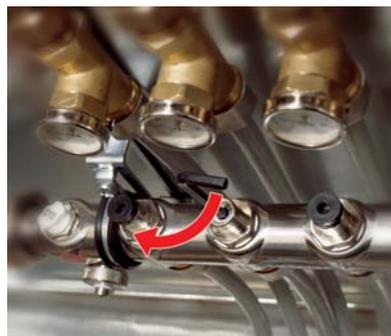
Шестигранным ключом на 5 мм перекрыть вентиль – нулевое положение.
