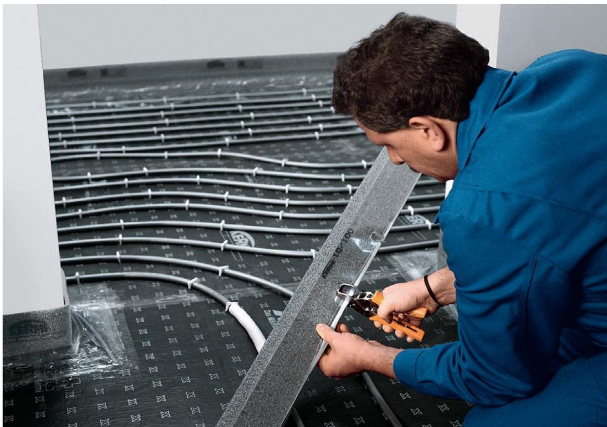
Снять клейкую защитную полосу ...
