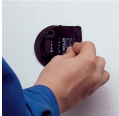
Готовые для включения в штекерные разъемы регуляторы температуры в помещении системы xnet требуются лишь для ввода установки в эксплуатацию. Они включаются простым вставлением в штекерный разъем. Механизм блокировки обеспечивает защиту от случайного выпадения.
