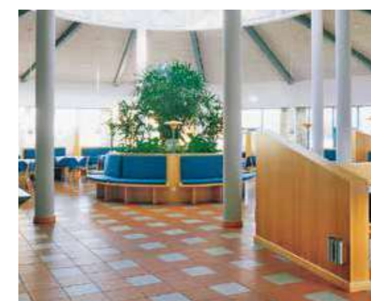
Обеспечивается комфортная температура по всей поверхности как для системы отопления, так и охлаждения
