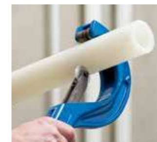
1 Отрежьте трубу под прямым углом.
