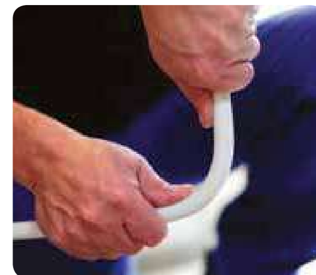
Сгибание трубы Uni Pipe Plus
