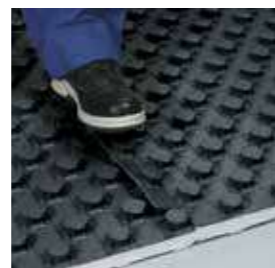
Панели укладываются и соединяются внахлест без какого-либо специального инструмента
