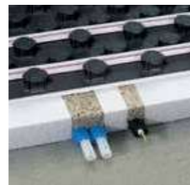
Вариант укладки с дополнительной изоляцией
