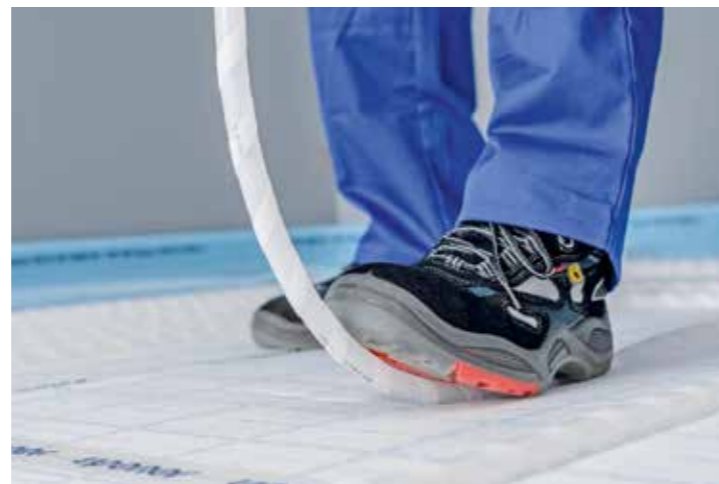
Чтобы закрепить трубу достаточно просто прижать ее, например, ногой к поверхности специальной панели (рулона)
