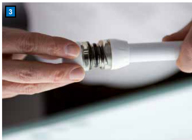
Опрессовка Вставьте трубу в фитинг до щелчка
