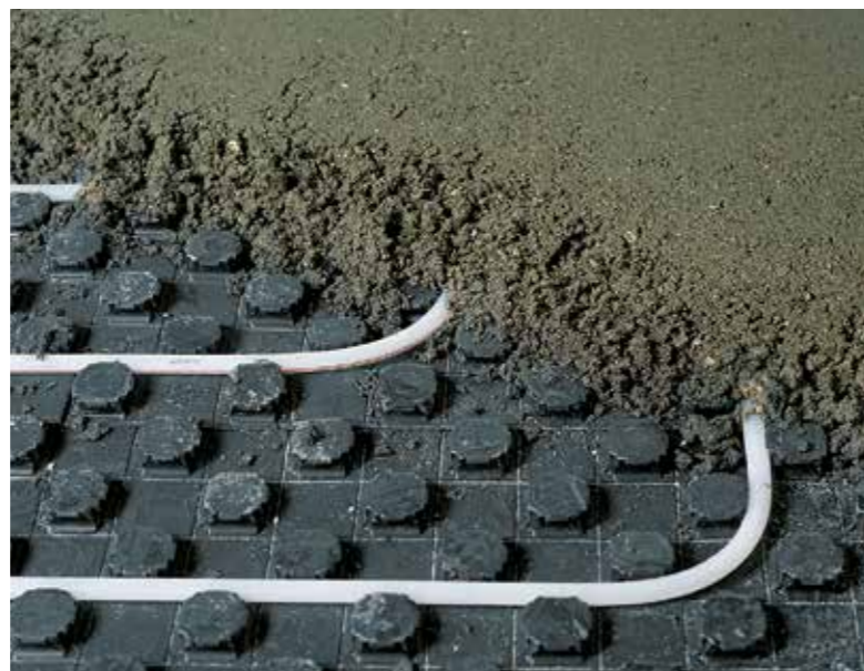
Свойства цементных дстяжек в соотв. с DIN 18560 могут быть улучшены специальными добавками Уропог
