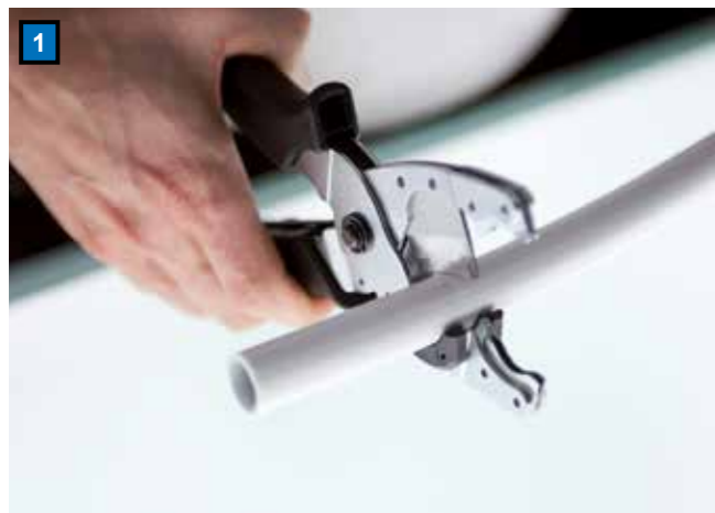
Обрезка трубы Отрежьте необходимую длину трубы подходящим инструментом под прямым углом
