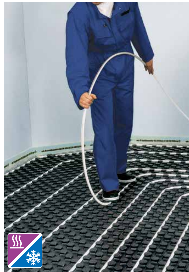
Панели укладываются и соединяются внахлест без какого-либо специального инструмента
