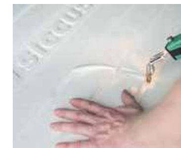
Дополнительные каналы могут быть выпилены электроинструментом
