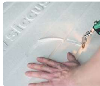
Дополнительные каналы могут быть выпилены электроинструментом
