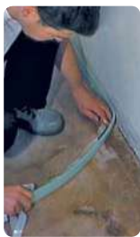
Установка демпферной ленты Upronor Minitec
