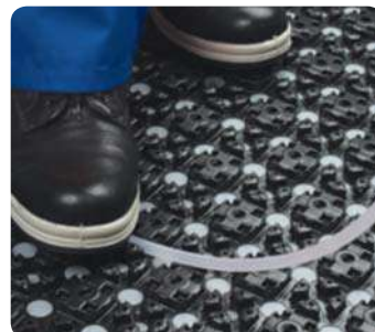
Монтаж силами всего одного человека
