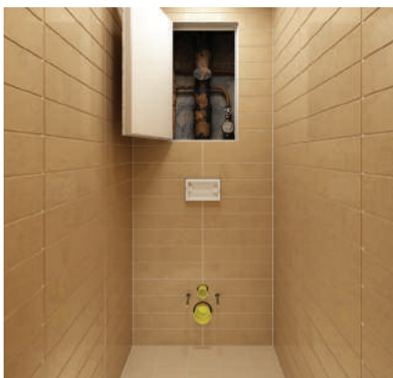
Укладка плитки и затирка стыков.
