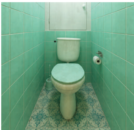
Типовой санузел до реконструкции.
