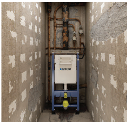
Надежность конструкции обеспечивается креплением к задней капитальной стене шахты и полу.
