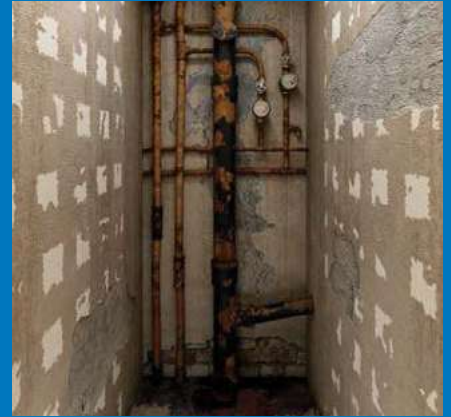
Типовой санузел готов к установке новой системы.
