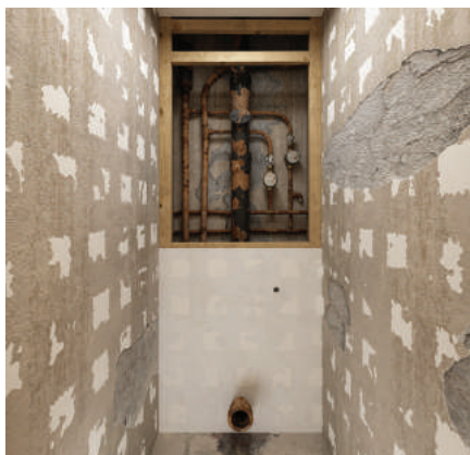
Плитка, старый унитаз и задняя стенка удалены.
