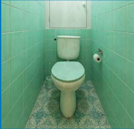
Типовой санузел до реконструкции.
