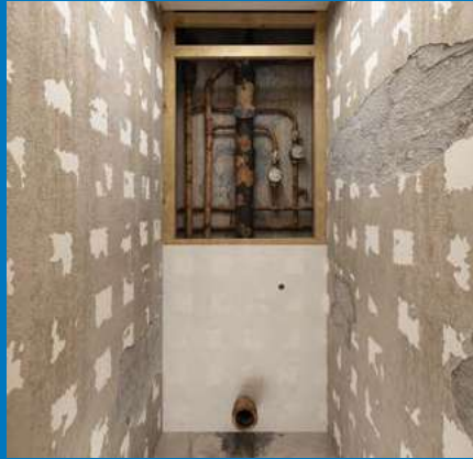
Плитка, старый унитаз и задняя стенка удалены.
