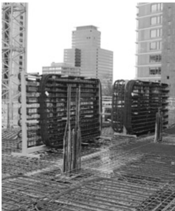
Подогрев и охлаждение ядра бетонных перекрытий
