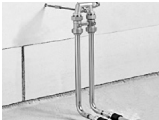
Готовый монтажный блок для подключения отопительного прибора.
