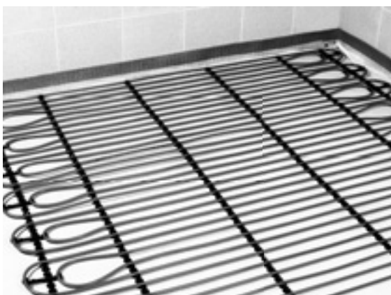
Система напольного отопления/охлаждения («мокрый» способ укладки труб)
