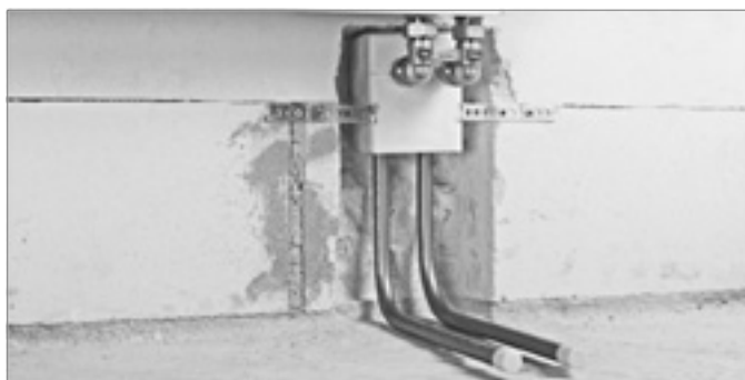
Присоединительный блок RAUTITAN для подключения отопительного прибора
