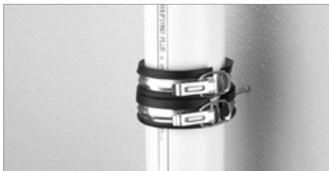
Запатентованная техника крепления RAUPIANO Plus к стене
