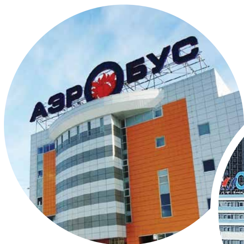
Торгово-офисный комплекс «Аэробус» Москва, Варшавское ш., 95
