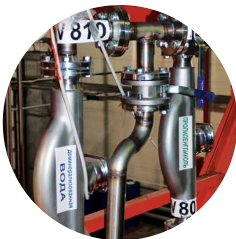
Кориолисовые расходомеры высокой точности (Endress+Hauser)
