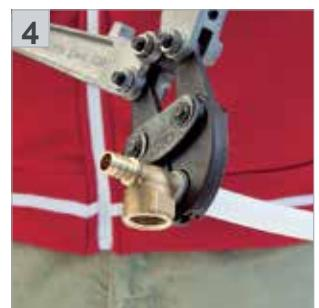
Поместите инструмент таким образом, чтобы обжимное кольцо полностью было закрыто захватами инструмента. Держите инструмент под углом 90° к фитингу, и сожмите его полностью.
