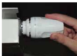
Установить желаемые температурные параметры, вращением ручки термоголовки.
