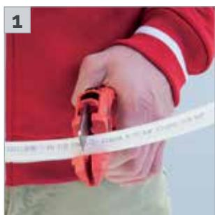
После того, как Вы отрезали трубу проверьте сечение на отсутствие заусенцев. Наличие заусенцев может привести к неправильному соединению.
