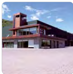
NEW PRODUCTION UNIT San Maurizio d'Opaglio (NO)
