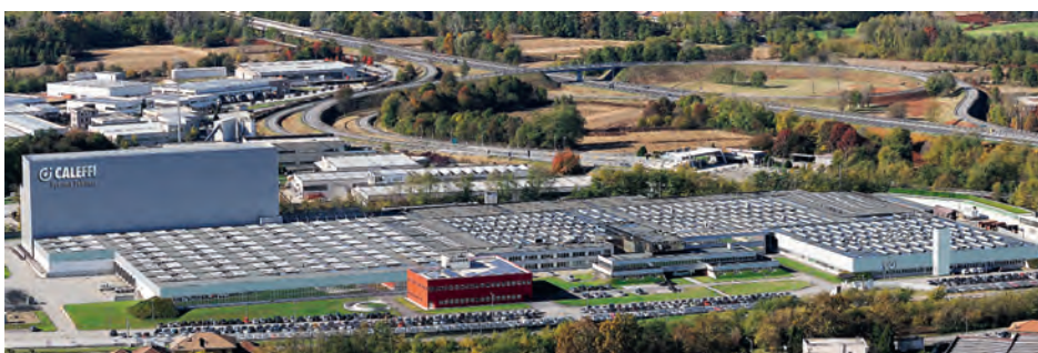
Caleffi S.p.A. - Центральный Офис - Предприятие 1 Фонтането д'Агонья - ИТАЛИЯ
