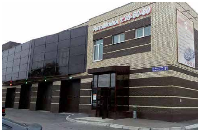
Автосервис, г. Йошкар-Ола Общая мощность котельной — 500 кВт
