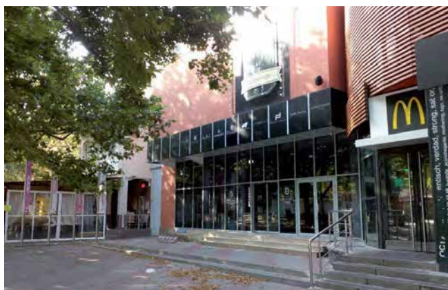
Ресторан McDonald's, г. Геленджик Общая мощность котельной — 140 кВт
