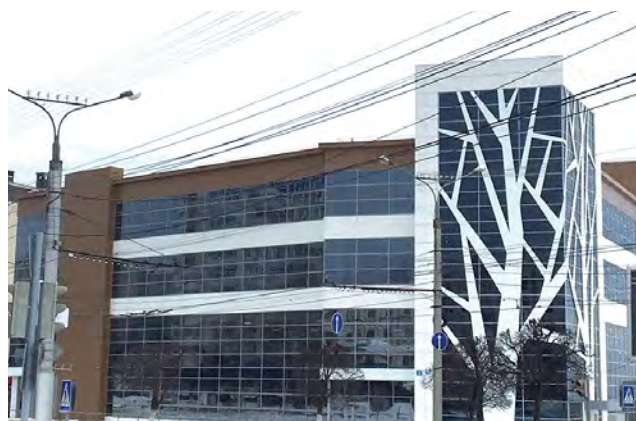
МФЦ, г. Чебоксары Общая мощность котельной — 1 МВт
