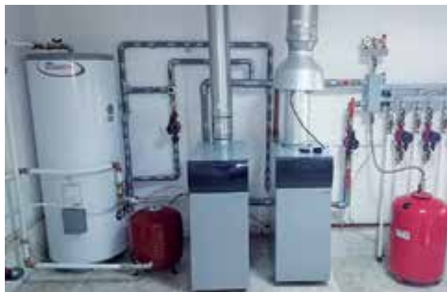
Жилой дом, г. Электросталь Общая мощность котельной — 92 кВт
