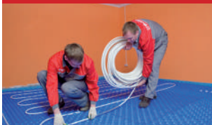
7. Укладка петель теплого пола (металлополимерная труба VALTEC).
