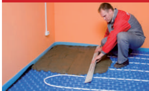
10. Заливка бетонной стяжки с пластификатором
