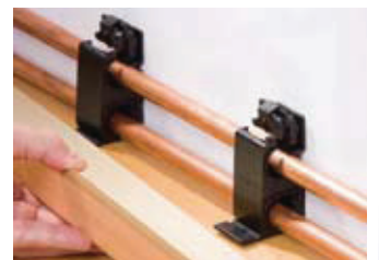
4. Вставить плинтус в нижние кронштейны крепежей
