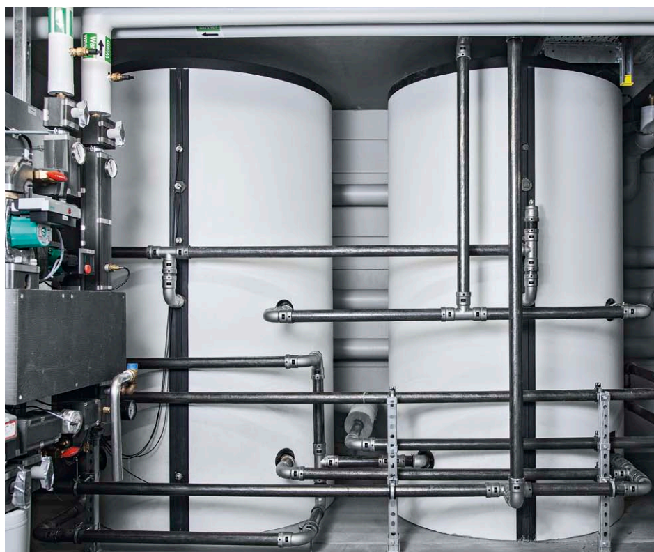
Megapress в системе отопления с буферными емкостями.
