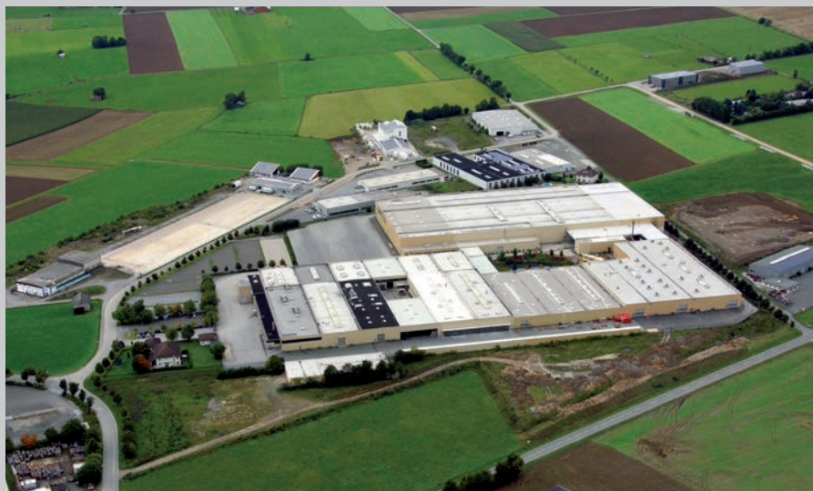
Производственный комплекс в Брилоне
