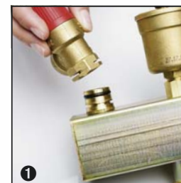
1. Предохранительный клапан повернуть на 360°.
