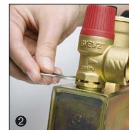
2. Направление сбросного отверстия может быть установлено в любую сторону.
