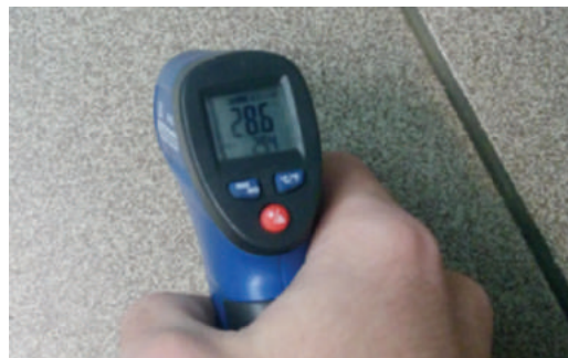
Рис.10 Замер температуры пола пирометром
