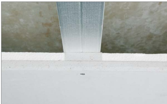
Рис. 4-6 Крепление потолочных панелей
