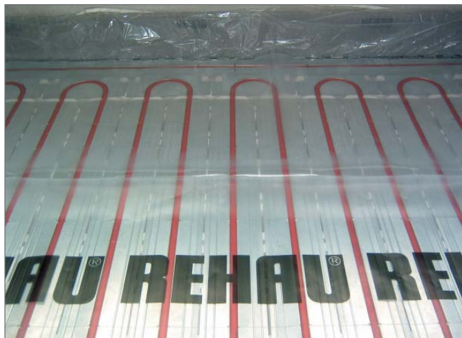
Рис. 3-59 Система укладки труб на теплоизоляционных матах TS-14
