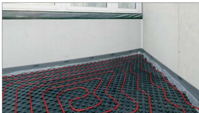
Рис. 3-11 Маты с фиксаторами Varionova с шаго-звукоизоляцией 30-2 снизу
