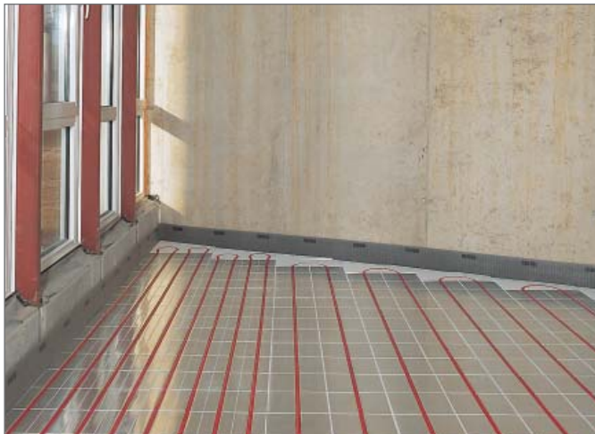
Рис. 3-49 «Сухая» система укладки труб
