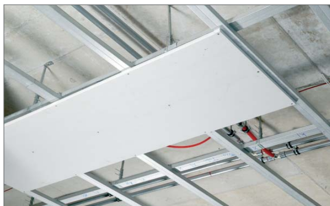
Рис. 4-34 Стеновая панель обогрева и охлаждения, смонтированная на потолке
