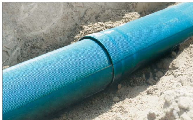
Рис. 9-33 Укладка дренажа на игровом поле
