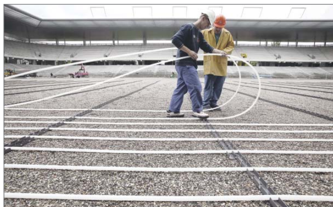
Рис. 9-34 Укладка отопительных труб
