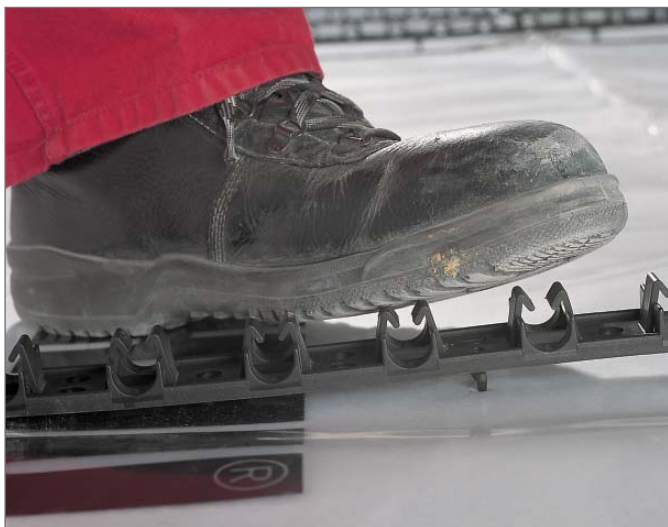
Рис. 3-34 Вдавливание фиксирующих шин RAUFIX в конструкцию пола
